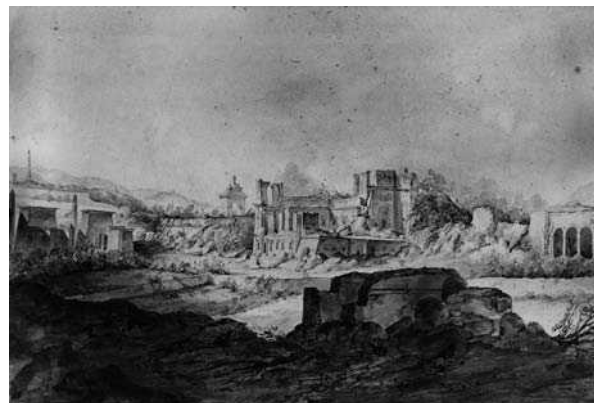
Fig. 3. I danni prodotti dai cannoneggiamenti del 1849 , litografia (Roma, Istituto Storico per il Risorgimento).
