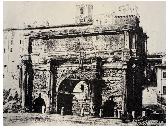
G.Caneva Restaurations at the Arco di Settimio Severo , 1850 c
